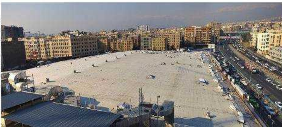
آب بندی بام ابنیه - پروژه مجتمع مسکونی استاد
