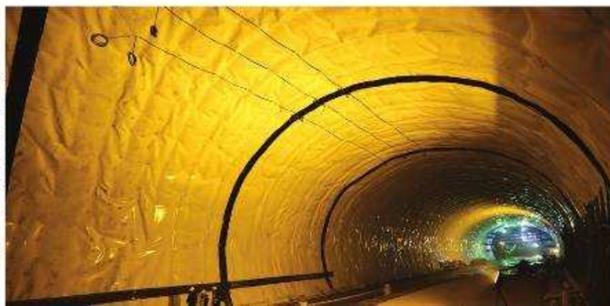
زهکشی و آب بندی - پروژه تونل سهندبار
