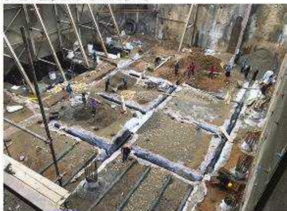
زهکشی و آب بندی سازه ای - پروژه سروستان
